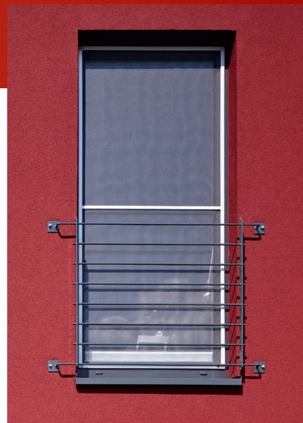
Französischer Balkon mit dem Tragwinkel TRA-WIK-ALU-RF auf der Fassade befestigt.
