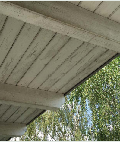
Tauwasser, z. B. auf Dachuntersichten oder gedämmten Fassaden, erhöht das Befallrisiko.
