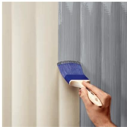
Die Zwischen- und Schlussbeschichtung mit Lignodur UltraGuard 580 wird leicht streifig ausgeführt.
