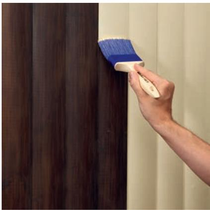
Der dunkel lasierte Untergrund wird mit Impredur Grund 835 im vorgegebenen Farbton abgedeckt.
